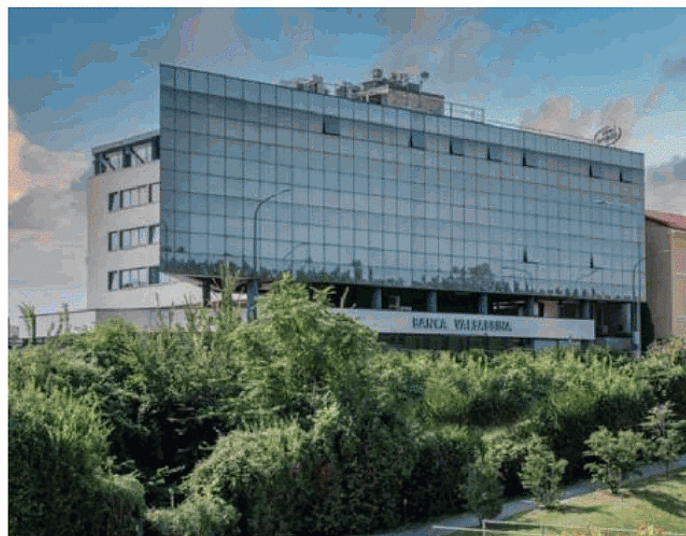
A Brescia Una veduta del quartier generale di Banca Valsabbina: il 2026 è iniziato subito ok
