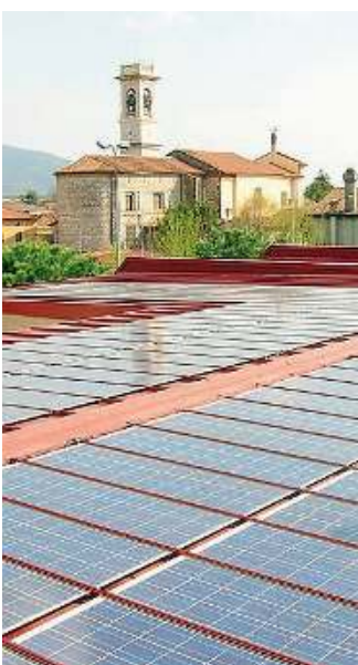
Energia. Boom del fotovoltaico
