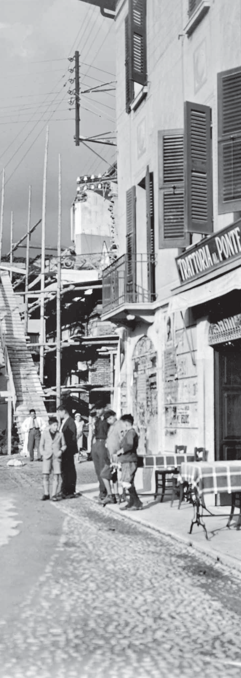
Gavardo - tratto di via Andrea Gosa durante i lavori di sistemazione del 1935
